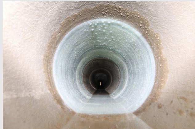
Bild 10: Kurzliner werden vollflächig verklebt (rechts), deswegen ist eine korrekte Vorbehandlung mit einem Fräsroboter unerlässlich (links)
