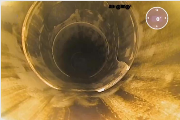
Bild 10: Kurzliner werden vollflächig verklebt (rechts), deswegen ist eine korrekte Vorbehandlung mit einem Fräsroboter unerlässlich (links)
