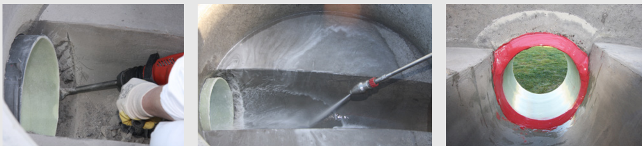
Bild 8: Auch bei der Schachtanbindung sind es die gleichen vorbereitenden Arbeitsschritte: Freistemmen (links), Reinigen (mittig), Abdichten (rechts)
