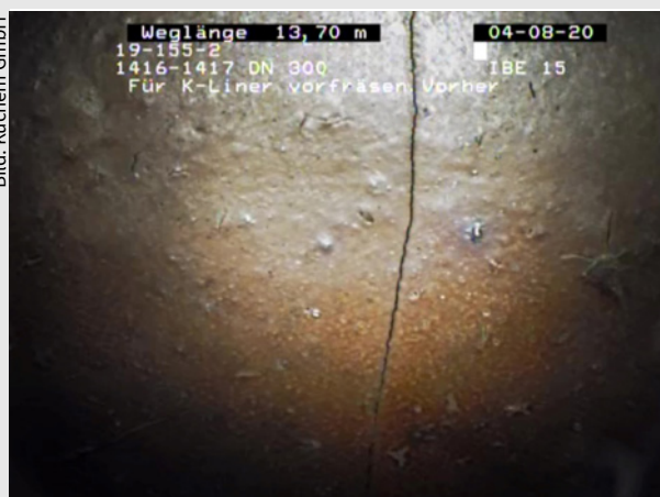
Bild 1: Deutlich zu erkennen ist die Sielhaut. Auf diesem Untergrund klebt auch das beste Harz nicht
