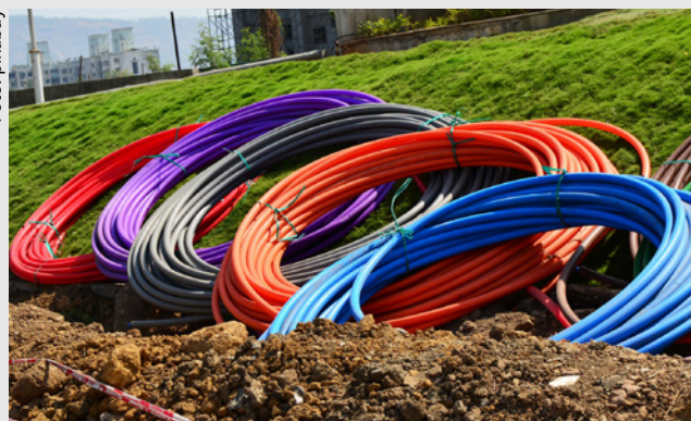
Bild 1: Um ein flächendeckendes Breitbandnetz in angemessener Geschwindigkeit nach den anerkannten Regeln der Technik und auf höchstem Qualitätsniveau zu errichten, gilt es zunächst, planungs- und bauseitig grundlegende Weichenstellungen vorzunehmen.
